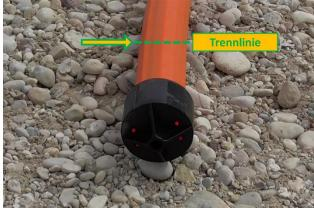
Zum Entfernen der permanenten Abdichtkappe Rohrverband ca. 10-15cm hinter der permanenten Abdichtkappe (Kennzeichnung Pfeil) abschneiden. Der Rohrverband kann dann normal weiterverwendet werden.
