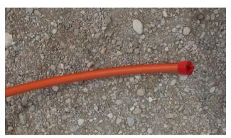
1.1 Während dem Verlegen von Rohrverbänden soll eine temporäre Abdichtkappe verwendet werden. Nach dem Ausrollen/Verlegen soll der Rohrverband in gestreckter Form im Graben liegen. Die temporäre Abdichtkappe kann jetzt abgeschraubt werden.
