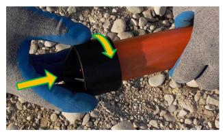
1.6 Abdichtkappe auf den Rohrverband drücken und gleichzeitig im Uhrzeigersinn drehen. Abdichtkappe bis zum Anschlag (handfest) aufdrehen.
