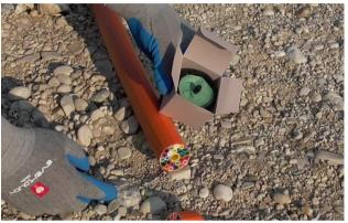
1.4 Zum Rohrverband passende Kappe aus der Verpackung erst jetzt entnehmen, um Verschmutzung der Dichtmasse zu vermeiden.
