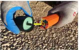
1.5 Zentrierdorn in das Zentralrohr einführen. **Hinweis**: Bei Rohrverbänden ohne Zentralrohr, den Zentrierdorn in das in der Mitte liegende Mikrorohr einfügen.
