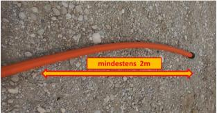
Bei Verwendung der permanenten Abdichtkappe ist es wichtig, dass 2m des Rohrverbandmantels auf dem Rohrverband verbleiben (z.B. bis zum 1. Abzweig). Dadurch wird die dauerhafte Dichtigkeit der permanenten Abdichtkappen gewährleistet.
