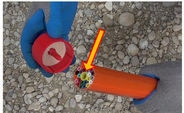
1.5 Zentrierdorn in das Zentralrohr einführen. Hinweis: Bei Rohrverbänden ohne Zentralrohr, den Zentrierdorn in das in der Mitte liegende Mikrorohr einfügen.
