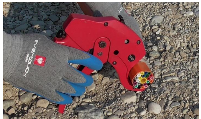
1.3 Das Ende des Rohrverbandes rechtwinkelig abschneiden.
