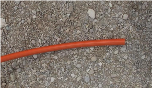
1.1 Während dem Transport oder Verlegen von Rohrverbänden soll eine temporäre Abdichtkappe verwendet werden. Zur Montage den Rohrverband für etwa 1m Länge in möglichst gestreckte Form bringen.
