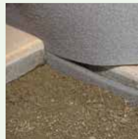
vdw 884 FugenBand 10 mm tief abtrennen
