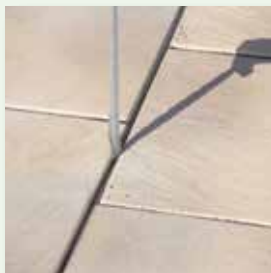
Fugenbandreste komplett entfernen
