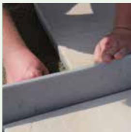
vdw 884 FugenBand im Bettungsmörtel einbringen
