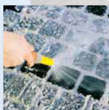
mit Wassersprühstrahl und feuchtem Besen abreinigen
