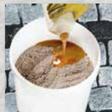
Bindemittelkomponente zugeben
