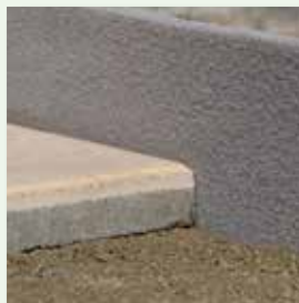
Anschließenden Belag druckfrei verlegen
