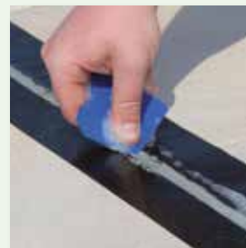
Fugenmasse verdichten und abziehen
