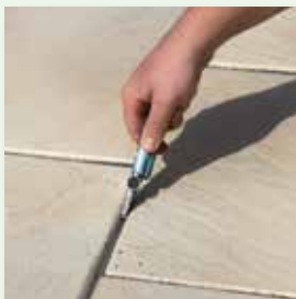
Hierzu Schnittkante FugenBand einkerben
