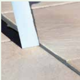
Klebebänder direkt im Anschluss entfernen
