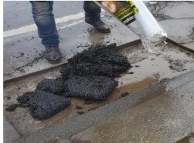
Kaugummi-asphalt® ist bei jedem Wetter einbaufähig, auch bei Schnee und Regen von -10°C bis +45°C.
