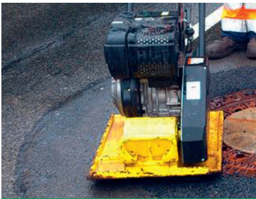
Größere Flächen mit Vibroplatten
