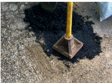
Kleinere Flächen mit Handstampfer (Schlaglöcher)
