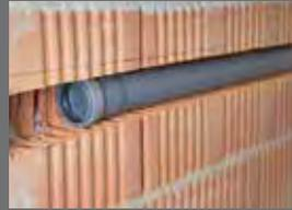
Sparen Sie sich den 2. Schlitzvorgang bei stärkeren Röhren mit Dämmung/Abwasserrohren Ø 40, 50 mm!
