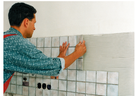
Die Fliesen rutschen nicht ab und können noch einige Zeit ausgerichtet werden.
