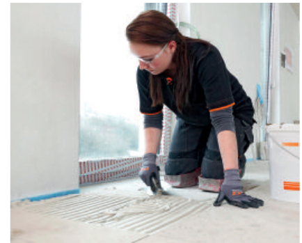
Mit PCI Carrament ® weiß können Naturwerksteinbeläge sicher im Mittelbettverfahren verlegt werden.
