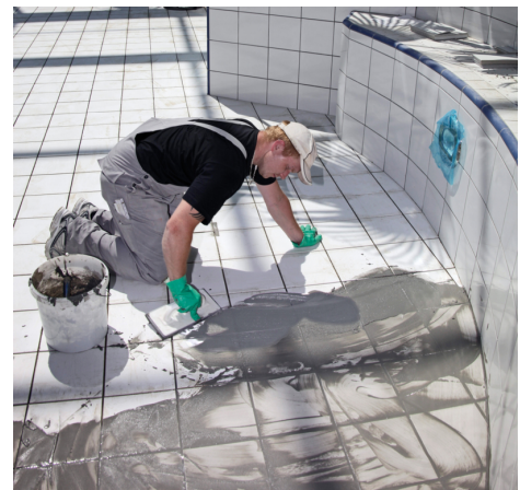
PCI Durafug NT zum Verfugen von keramischen Belägen mit erhöhter mechanischer Belastung und Beanspruchung, z. B. in Schwimmbädern.
