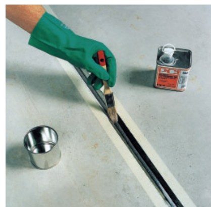
Vor dem Verfugen die gereinigten Fugenflanken mit PCI Elastoprimer 110 bis zur Sättigung mit einem Pinsel grundieren. Nach einer Ablüfzeit von min. 50 Minuten und max. 2 Stunden...
