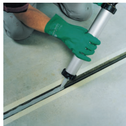
...die Bodenfugen mit PCI Elritan 140 schließen.
