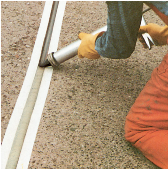
Elastisches Schließen einer befahrenen Bewegungsfuge in einem Betonboden.
