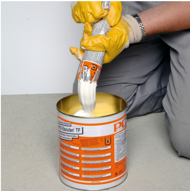
Zugeben des Härters zur Basis-Komponente.
