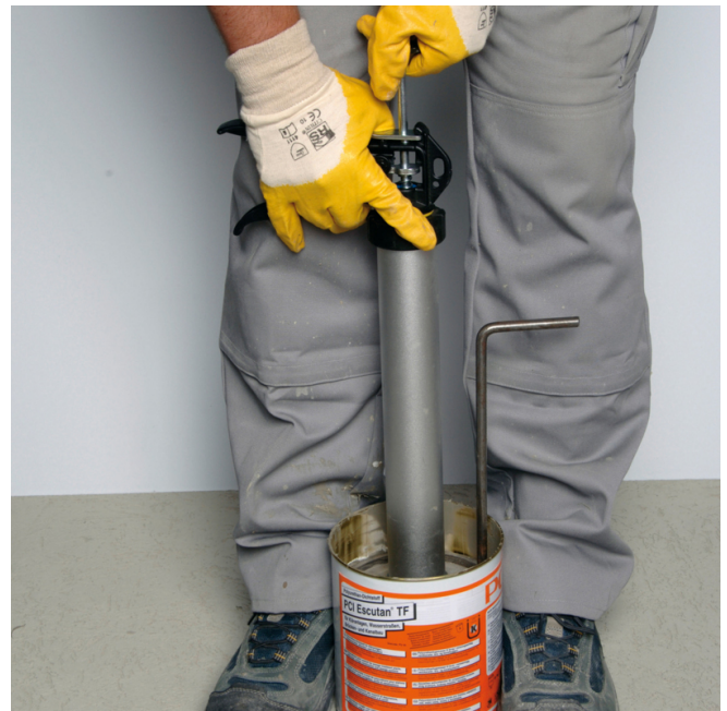
Abfüllen von PCI Escutan TF in eine Spritze mittels Saugplatte.
