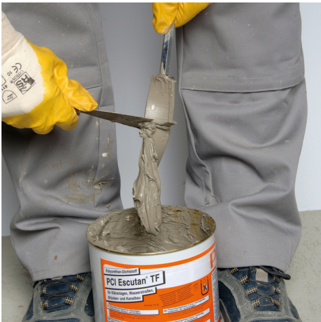
Vorreinigen des Rührwerkzeugs.
