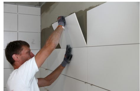
Funktionssichere Fliesenverlegung im Dünnbettverfahren mit PCI FT Klebemörtel
