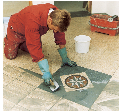
Die Fugen bei Feinsteinzeugbelägen können in einer Breite von 1 – 10 mm mit PCI FT ® Megafug verfugt werden.
