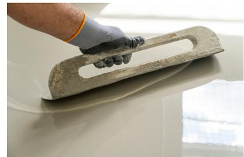
PCI FT Plan Fein überzeugt vor allem in dünneren Schichtdicken bis 10 mm mit guten Verlaufs- und Verarbeitungseigenschaften
