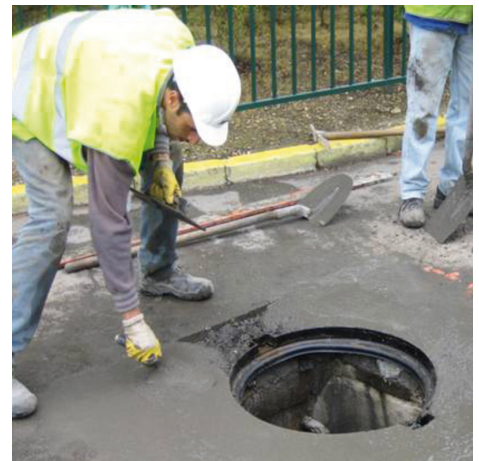
Einbetten eines Schachtringes mit PCI Repafast Tixo
