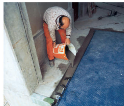
Kraftschlüssiger Verguss von Einbauteilen mit PCI Repaflow Turbo am Beispiel einer Laderampe.
