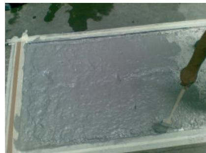
PCI Repahaft EP sorgt für ausgezeichnete Haftung zwischen Beton und frischen Mörteln.
