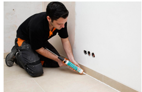
Elastisches Schließen von Boden-Wand-Fugen mit PCI Silcoferm S ohne störende Geruchsbelästigungen während und nach der Verarbeitung.
