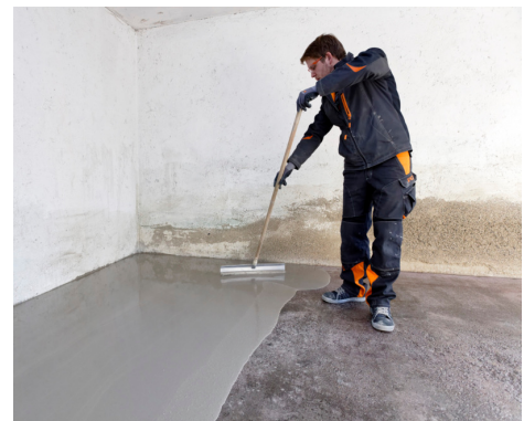
Vollflächiger Bodenausgleich mit leicht verlaufendem PCI Zemtec ® 1K für direkte Nutzbarkeit.
