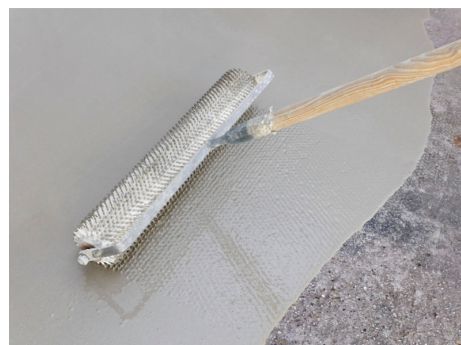
Auf der klebefreien, ausgehärteten Grundierung ausgegossenes und verteiltes PCI Zemtec 1K während des Einbaus mit einer Stachelwalze egalisieren und entlüften.
