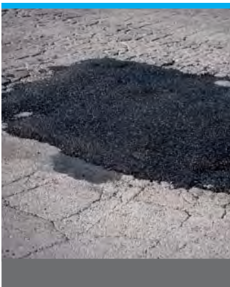
Dauerhafte Reparatur von Schlaglöchern Permanent pothole repair
