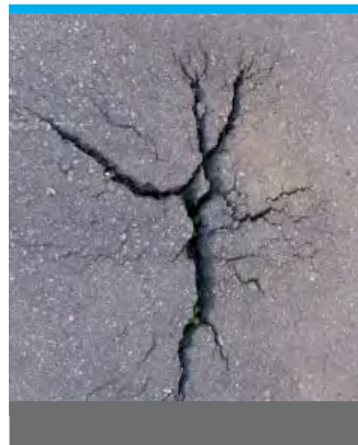
Verfüllung von Frostaufbrüchen und breiten Rissen Backfilling of frost heaves and wide cracks
