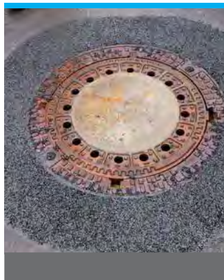
Kanal- und Schachtsanierungen Sewer and manhole rehabilitation
