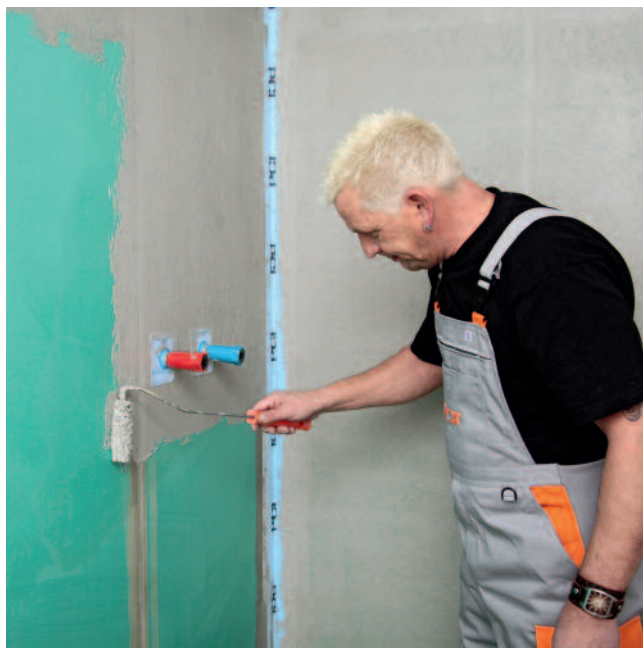
4. Erste Schutzschicht mit PCI Lastogum (grau) unverdünnt satt und oberflächendicht auf den Untergrundauftragen.
