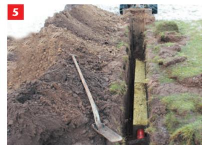
Anschließend wird die Grube lagenweise und gleichmäßig verfüllt und verdichtet. Beachten Sie, dass lehmhaltiges Material prinzipiell nicht geeignet ist. Die Geländeoberfläche und der Geländeunterbau müssen entsprechend der zu erwartenden Belastung vorbereitet werden.
