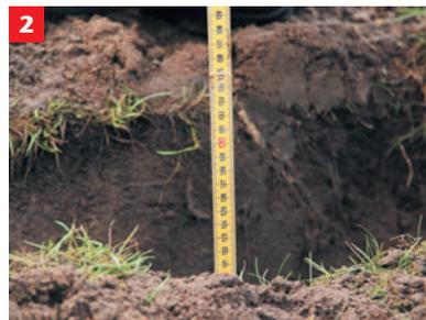
Der Graben muss min. 125 cm tief sein. Ziehen Sie die Grundfläche der Grube waagrecht ab.
