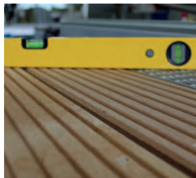
Kontrolle der Einbauhöhe
