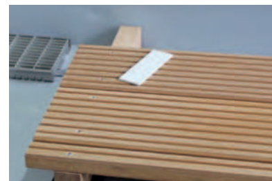
Rinnenkörper nach Notwendigkeit bau-seits unterfüttern
