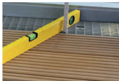
Einpassen der Holzterrassenrinne
