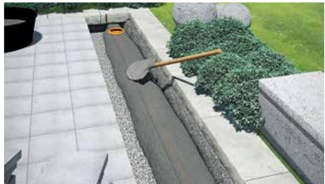
Beton einfüllen und zu Fundament verdichten.
