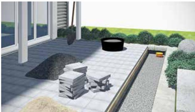
Verlegegraben und frostsicheren Unterbau herstellen.
