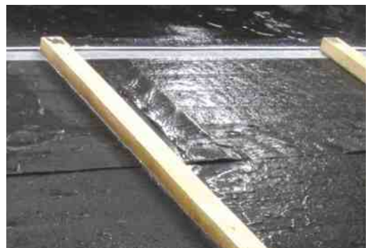
Sofort regensicher nach Verklebung
