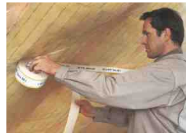
Klimamembran Vario KM in Abständen von ca. 20 cm am Sparren antackern. Auf leichten Durchhang pro Sparrenfeld achten (ca. 3 cm). Klebeband Vario KB 1 über die Folienstöße kleben, andrücken.
