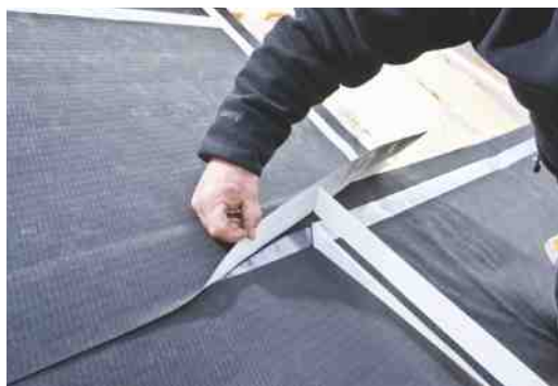
Klebebänder ober- und unterseitig integriert
