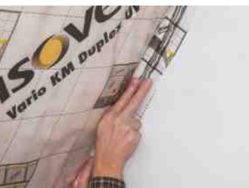
Dichtstoffraupe mit den Fingern V-förmig andrücken (Durchmesser 6 - 8 mm)
