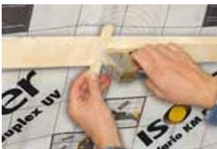
Bei GK-Bekleidung ist mit UniFix die Standard-Oberflächengüte Q2 problemlos erreichbar. Für höhere Oberflächengüten Integra UMB 30 verwenden. ISOVER UniFix Universal-Montagestreifen sind dem Untersparren-Klemmfilz kostenlos beigelegt.
