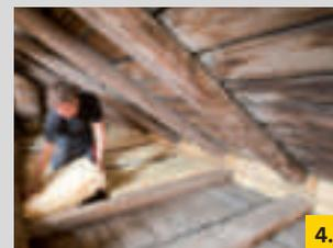
**1.** Wenn statt der zuvor beschriebenen Variante eine Dämmung eingebracht werden soll, die nicht oder höchstens zu Servicezwecken begehbar sein soll, kommt Topdec DF 1-035 RENO zum Einsatz.
