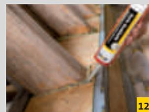
**9.** Wenn die Balken so aussehen, ist ein Anschluss der Klimamembran mit Klebebändern oder Dichtstoff unmöglich.
