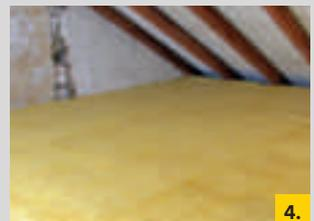
**4.** Fertig verlegte Dämmschicht – nur sporadisch begehbare.
