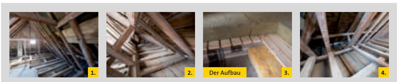
**1.** Die zu dämmenden Bodenflächen sind in einigen Teilbereichen direkt zugänglich, in anderen durch eine darüberliegende zweite Balkenlage in der Höhe begrenzt.
