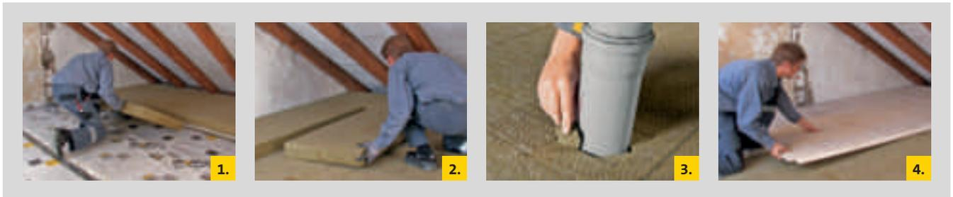
**1.** Auslegen von Topdec Loft auf der luftdicht verklebten Dampfbremse ISOVER Vario KM Duplex UV.
