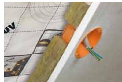
Für Elektroverteilungen und -dosen ist eine Installationsebene notwendig. Diese sollte mit Dämmstoff gefüllt werden.
