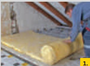
**1.** Ausrollen von Topdec Deckenfilz auf der luftdicht verklebten Geschossdecke.
