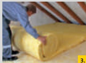
**3.** Eine zweite Dämmlage mit versetzten Stößen erhöht die Dämmwirkung und bietet zusätzliche Sicherheit gegen Wärmebrücken.
