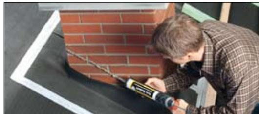
Ganz gleich welche Situation Sie auf der Baustelle vorfinden, mit Vario DoubleFit haben Sie immer den passenden Problemlöser dabei. Denn Vario DoubleFit ist universell einsetzbar und erzielt bei allen Dampfbremsen auf unterschiedlichsten bauüblichen Untergründen (wie Mauerwerk, Beton, Porenbeton, Putz, Holz und Metall) optimale Ergebnisse.
