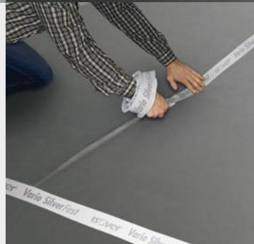
Aufgeworfene Falte anschließend überlappend glattziehen und mit Vario SilverFast verkleben.
