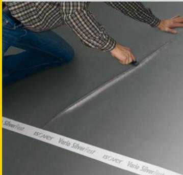
Bei Faltenbildung an komplizierten Stellen Unterdeckbahn durch Aufschneiden entspannen.
