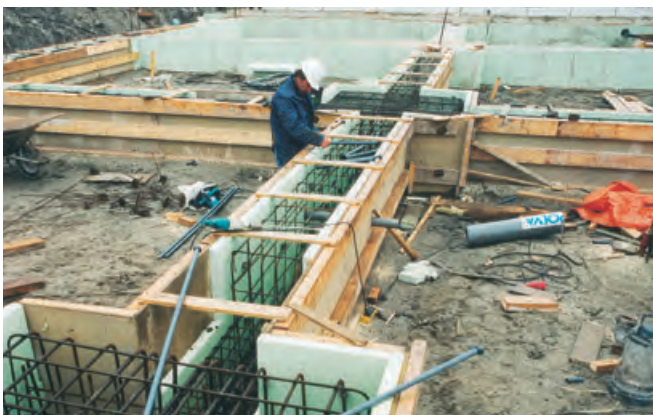
Abb. 25: Schalung mit Styrodur® C.
