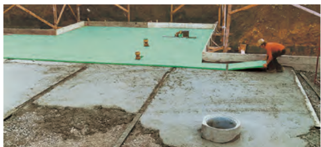
Abb. 6: Sauberkeitsschicht aus Magerbeton zur Verlegung der Bodendämmung.
