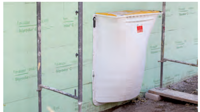
Abb. 22: Lichtschachtmontage bei Perimeterdämmung
