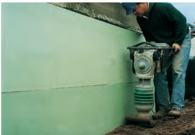
Abb. 28: Lagenweise Verfüllung der Baugrube und mechanische Verdichtung.
