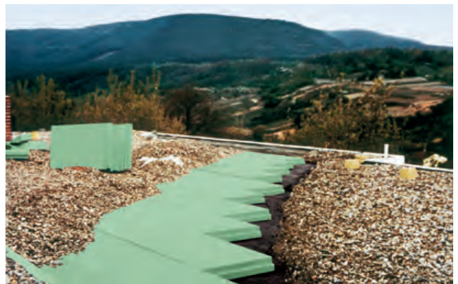
Abb. 47: Saniertes UK-Dach als Plusdachkonstruktion.
