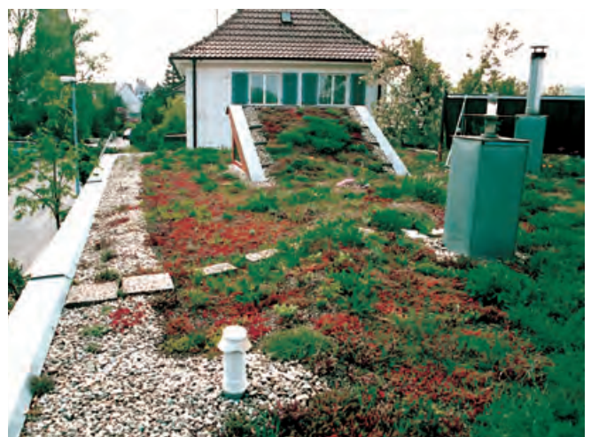
Abb. 66: Kiesstreifen am Dachrand und an Dachdurchdringungen.
