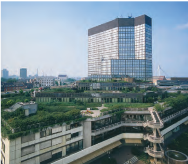
Abb. 58: Intensiv begrüntes Umkehrdach.
