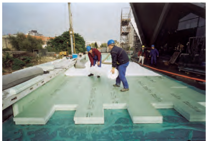
Abb. 45: Verlegung von Styrodur oberhalb der Dachabdichtung.
