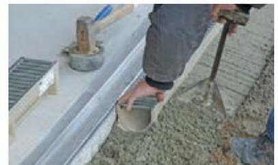
9. Seitliche Betonstütze gemäß Einbauempfehlung herstellen
