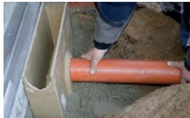
5. KG-Rohr mit Gleitmittel in den Einlaufkasten einsetzen.
