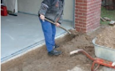
1. Bodenaushub nach Einbauempfehlung für ACO Self® Euroline: Rinnenstrang mit Einlaufkasten. (Einbaudetails zum Download unter: [www.aco-hochbau.de/service/technische-dokumente/](http://www.aco-hochbau.de/service/technische-dokumente/))
