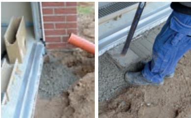
4. Einbringen des Rinnenfundamentes gemäß Einbauempfehlung. Verdichten des Rinnenfundamentes. Vorbereiten des Ablaufes DN 100.
