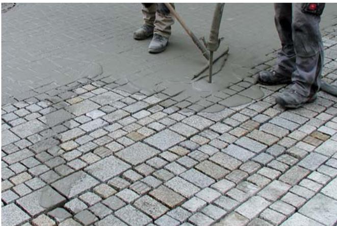
Bei der Siloverarbeitung (nur ZFM 500) wird das Material über eine Schlauchleitung auf der Fläche verteilt.
