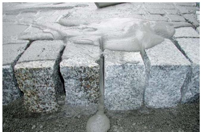
Durch die fließfähige Konsistenz dringt der Pflasterfugenmörtel in alle Hohlräume und verfüllt sie vollständig.
