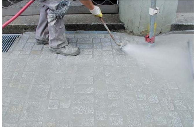
Anemulgieren und Abspülen der Fläche nachdem das Fugenmaterial angehärtet ist. Durch eine Daumenprobe wird dieser Zeitpunkt, der temperaturabhängig ist, ermittelt. (Achtung! Waschwasser nicht ungefiltert in die Kanalisation einlaufen lassen.)
