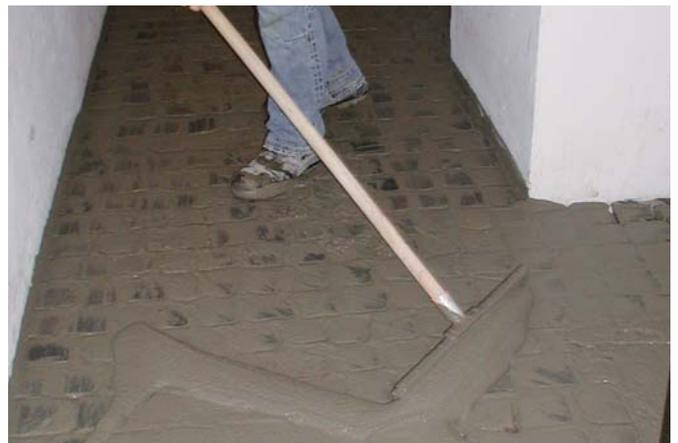
Verteilung und Einarbeitung des fließfähigen Pflasterfugenmörtels
