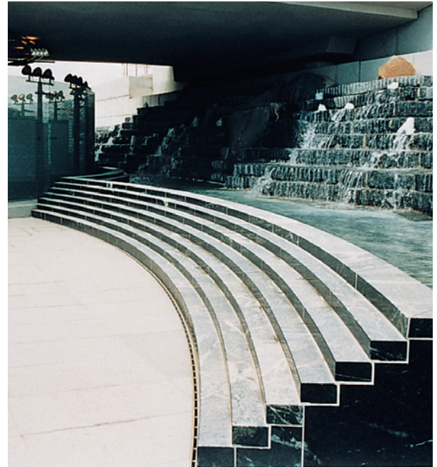
Flughafen Stuttgart, einseitig bündig im Bogen verlegt als Sonderanfertigung
