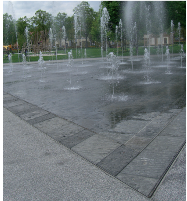
Fontänenfeld im Zentrum der Landesgartenschau, Aschersleben: Der nur 12,5 mm breite Schlitz im aufgesetzten Schlitzrahmen der Rinnen reicht aus, um das Oberflächenwasser sicher und schnell abzuleiten
