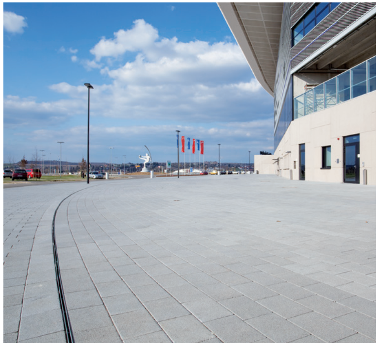
Erschließungsflächen vor der Arena: Die Verlegung der Rinnenkörper bzw. Schlitzrahmen erfolgte aus ästhetischen Gründen parallel zur bogenförmigen Stadionfassade
