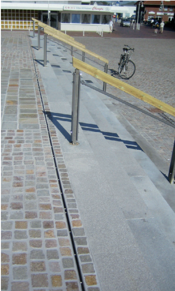
Oberflächenentwässerung dezent und elegant: Der Schlitzrahmen fügt sich unaufdringlich in die Freifläche mit Stufenanlage ein. Bauvorhaben: Westerland/Sylt
