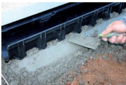
Das Einbetonieren der Rinne erfolgt bis zur Markierung am Rinnenkörper
