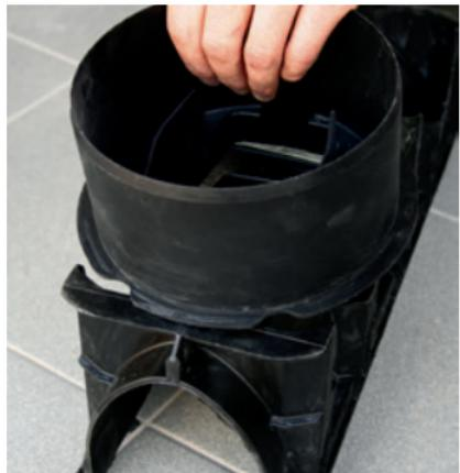
Einsetzen des Anschlussadapters für den Ablaufschacht
