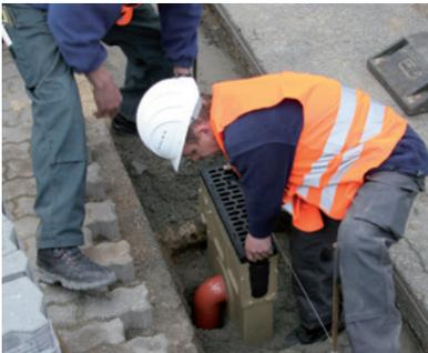
4. Anschließen des Stützens an den Einlaufkasten. Einsetzen und Anschließen des Einlaufkastens an die Grundleitung
