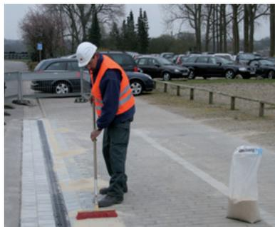
8. Verfüllen der Fugen mit Quarzsand
