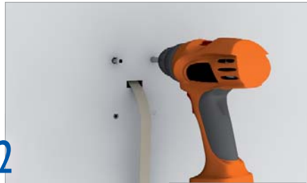
2 Vorbohren und Dübel setzen.
