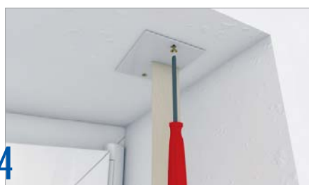
4 Abschließend die Gurtführung einsetzen und mit Senkkopf-Schrauben fixieren.
