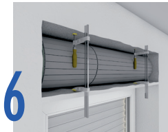
Dämmung fixieren (Spreize oder Dachlatte verwenden).
