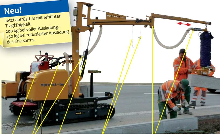
Allroundtalent für Palettentransport. Fahrwerk mit Gummiketten für unebenes Gelände, kombiniert mit einem Vakuum-Schlauchheber für Verlegearbeiten bis 200 kg Hubkraft. Spielend leicht lassen sich 250 – 500 Bordsteine pro Schicht verlegen.
