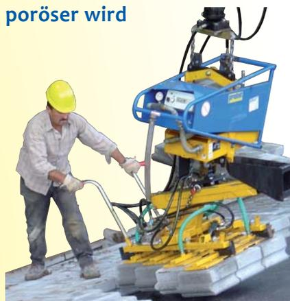
Oder wenn einmal eine diffizile Sonderlösung her muss. Die clevere Kombination aus TURBO-Kraft und einer speziellen Saugplatteneinheit von Probst Ingenieuren entwickelt, macht es möglich! Z. B. 12 Betonsteine mit Vertikalverbund zum Halbsteinverband zu verschieben und an der steilen Uferböschung millimetergenau in den Verband zu verlegen – kein Problem für die SH-UNI-TURBO.
