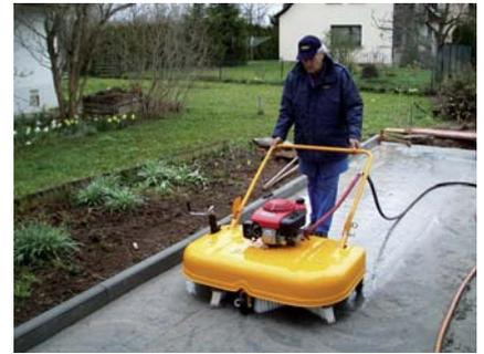
... beim Einsanden / Einschlämmen von Belägen: das Kraftsparpaket mit Drive – EASYFILL EF-H Pflasterverfugungsgerät.
