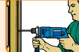
**7** Bohren Sie die Dübellöcher. Die Fuge zwischen dem Elementrahmen und Mauerwerk im Bereich der Befestigungspunkte mit Klötzchen hinterfütern.
