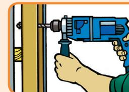
**10** Markieren und Bohren Sie analog den Punkten 6 und 7 die Dübellöcher, befestigen Sie den Rahmen mittels Rahmendübeln / Montageschrauben. Nochmals Funktionsprobe durchführen.
