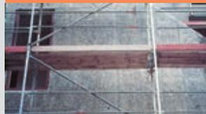
Werden häufig als Außen-Dämmung von Betonbauteilen verwendet. Um ein größeres Oberflächenvolumen und damit eine bessere Putzhaftung zu erreichen, muss mit einem volldeckenden Spritzbewurf gearbeitet werden. Er besteht in der Regel aus einem Gemisch aus Wasser, Sand, Zement und *Knauf Haftemulsion*.
