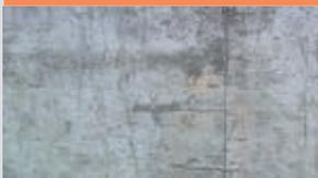
Besonders im Neubau darauf achten, dass die sogenannte Sinterhaut entfernt wird. Diese wirkt anderenfalls als Sperrschicht und beeinträchtigt die Haftung des Putzes. Ob der Beton eine Sinterhaut gebildet hat, lässt sich leicht durch gleichmäßiges Benetzen mit Wasser feststellen. Dabei soll die Farbe von hellgrau auf dunkelgrau wechseln. Die Sinterhaut
