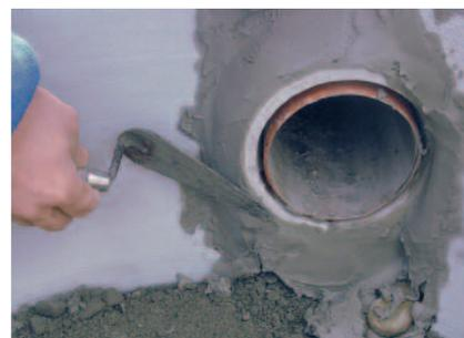
Schachtfutter einmörteln mit PCI Polyfix plus.
