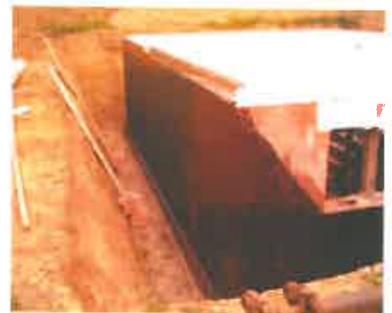
Abdichtung einer Kelleraußenwand aus Beton mit PCI Pecimor 2K. Geschmeidig-leichtes Verarbeiten durch Polystyrolfüllung.
