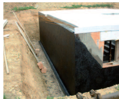
Abdichtung einer Kelleraußenwand aus Beton mit PCI Pecimor 2K. Geschmeidig-leichtes Verarbeiten durch Polystyrolfüllung.
