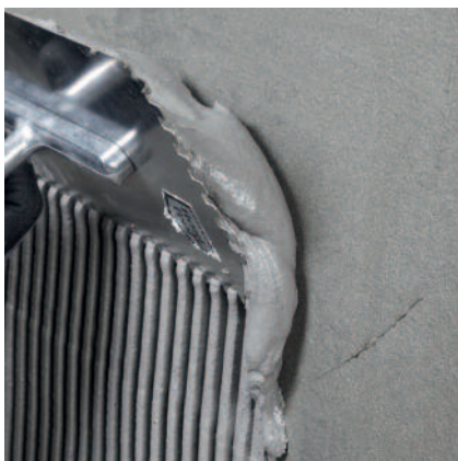
PCI Barraseal Turbo muss in mindestens 2 Abdichtungslagen aufgebracht werden. Zur Kontrolle der Schichtdicke kann das Material aufgezahnt und dann abgeglättet werden.
