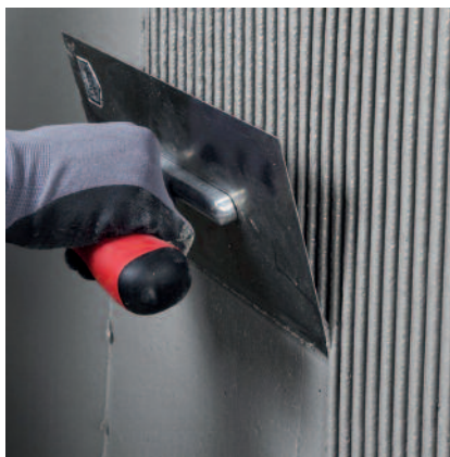
Das glätten der letzten aufgezahnten Schicht ergibt eine glatte und feinstrukturierte Oberfläche.
