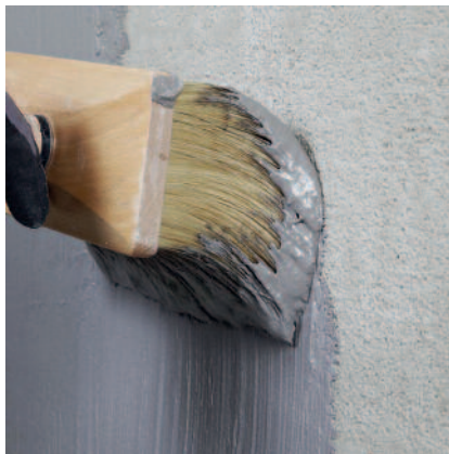
Aufbringen einer Kontaktschicht mittels Bürste oder Quast.
