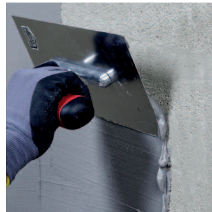
Eine Kontaktschicht kann auch in Form einer Kratzspachtelung aufgetragen werden.
