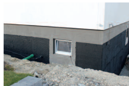
Sockel- und Sockelübergang mit PCI Barraseal Turbo im Anschluss an die erdberührte Pecimor-Abdichtung
