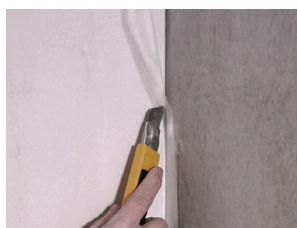
Abb. 14: Trennstreifen bündig abtrennen
