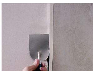
Abb. 13: Fugen fachgerecht verspachteln
