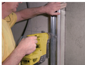
Abb. 11: Profil auf dem Untergrund befestigen
