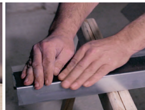
Abb. 9: Den Falz des Trennstreifens nachstreifen
