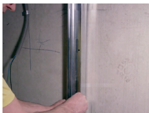
Abb. 10: Profil nach Herstellerangaben ansetzen
