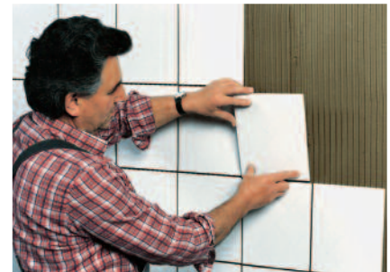
Funktionssichere Fliesenverlegung im Dünnbettverfahren mit PCI FT Klebemörtel
