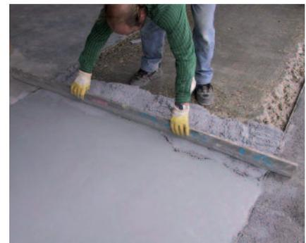
Mechanisch belastbare Flächen können ohne Grundierung mit PCI Repafast APS 40 bis - 25 °C instandgesetzt werden.
