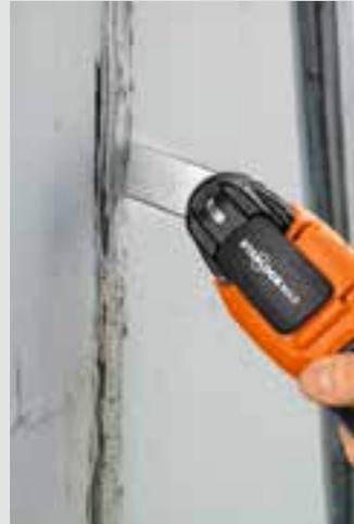
Entfernen von elastischen Fugendichtstoffen im Hoch- und Tiefbau.
