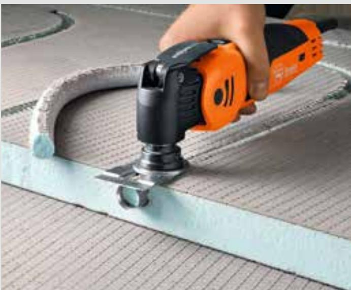
Kanäle für Warmwasser-Fußbodenheizung schneiden.
