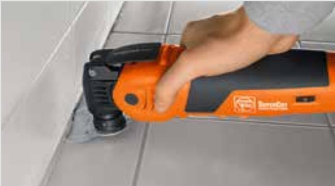
Elastische Fugendichtstoffe entfernen.
