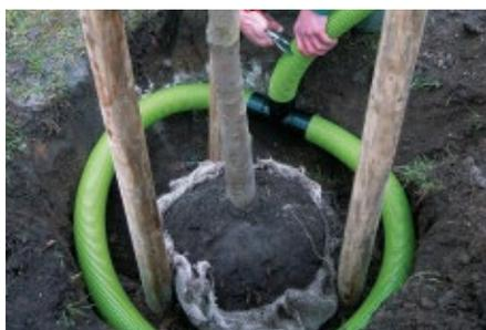
Durch einen zusätzlichen Rohrabschnitt wird eine Verbindung zwischen Ringleitung und Oberfläche hergestellt.
