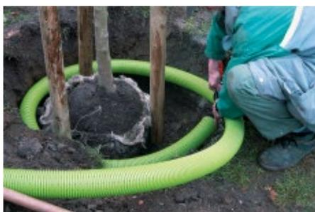
Das allseitig gelochte Baumerhaltungs-Rohr wird ringförmig im Wurzelbereich unter der Kronentraufe verlegt und mit dem T-Stück verbunden.
