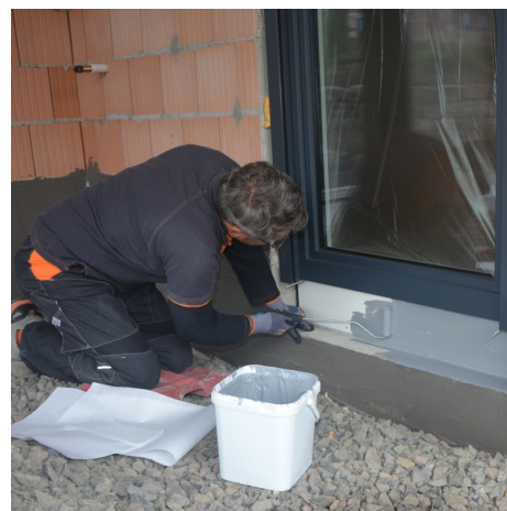
PCI Barraseal Ready mit einer kurzflorigen Rolle oder einem Pinsel flächendeckend auf den vorbereiteten Untergrund aufbringen.
