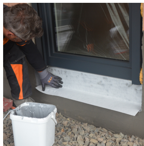
PCI Barraseal Ready Vlies vollflächig in die noch frische Schicht PCI Barraseal Ready einlegen und vorsichtig andrücken.
